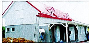
Le gros œuvre, la toiture, les portes, fenêtres et enduits sont terminés pour les deux premières maisons qui ont reçu les clés et de même plus que certaines finitions à effectuer.
